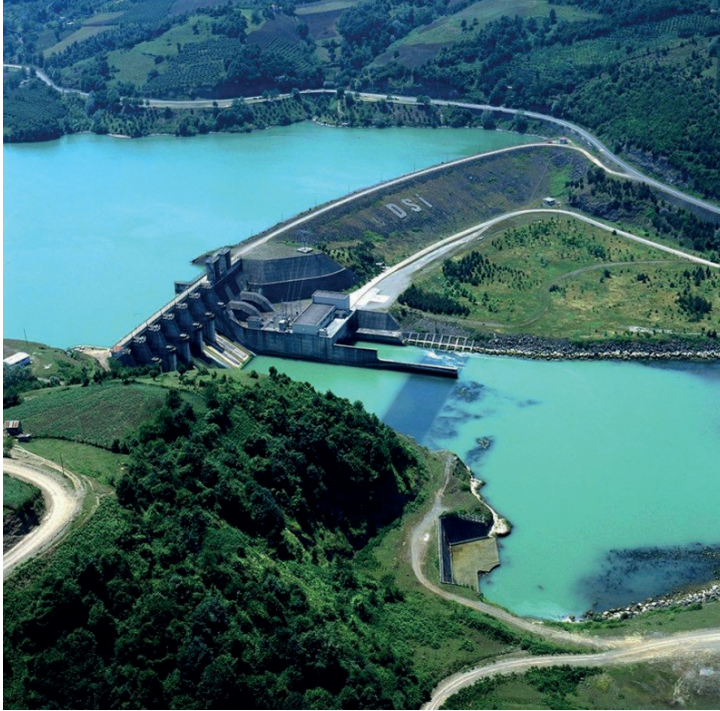
Şekil 9. Tamamlanmış bir baraj.
