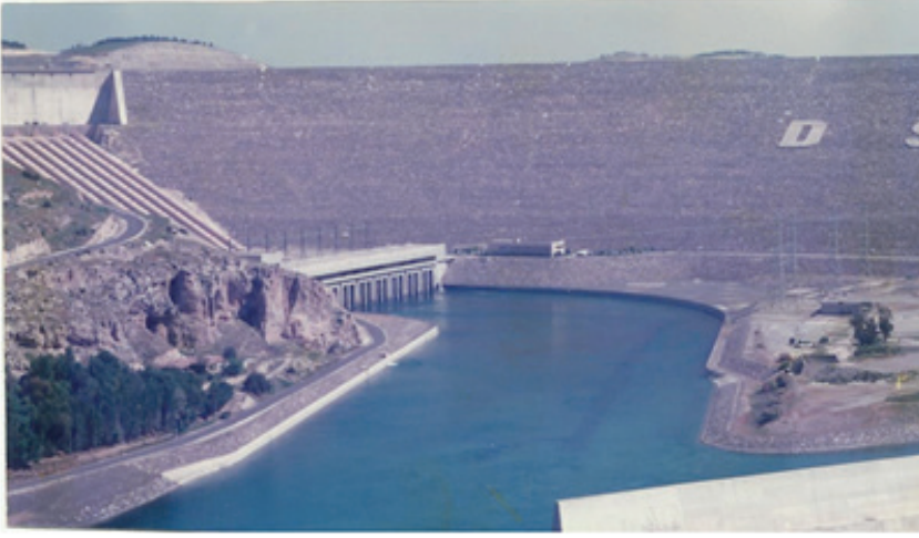
Şekil 6. Atatürk Barajı' nın işletme evresinden genel bir görünüm.
