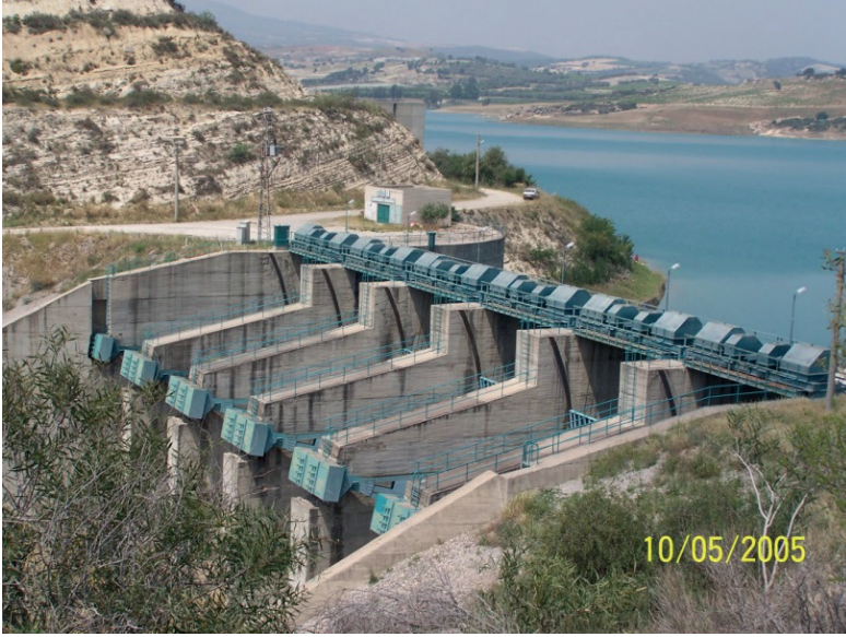
Şekil 8. Baraj Tesisi (Berdan Barajı, Tarsus).
