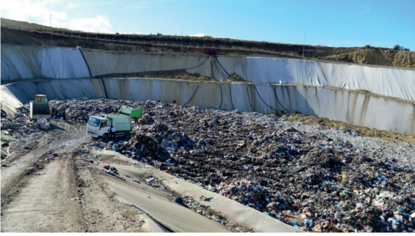
Şekil 4. Yeşilirmak Belediyeleri Katı Atık Yönetim Birliği Katı Atık Düzenli Depolama Tesis'i'nden bir görünüm ( http://www.iha.com.tr/etiket-kati-atik/ ).
