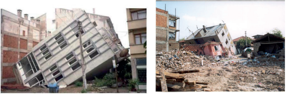
Şekil 4. Deprem sonucu oluşan sıvılaşmaya bağlı yıkılmalar (1999 Marmara Depremi).
