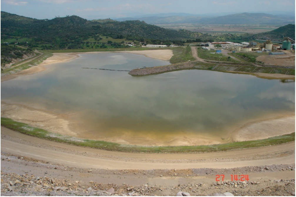
Şekil 7. Bir atık depolama tesisinin görünümü
