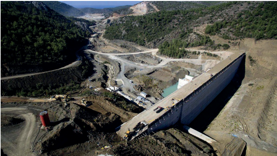
Şekil 12. Karareis Baraj inşaat evresi (İzmir).
