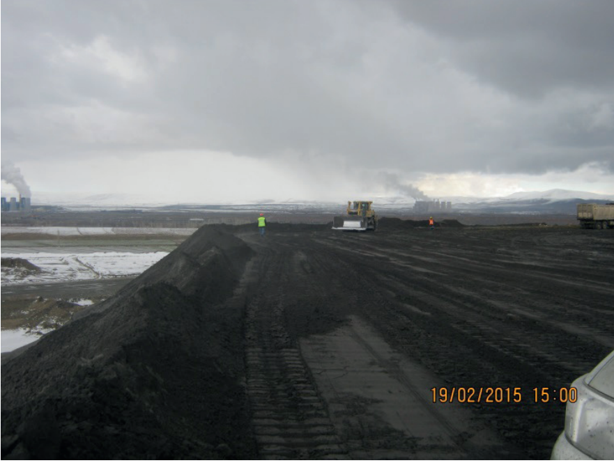
Şekil 14. Afşin – Elbistan Termik Santrali ve kül depolama sahası
