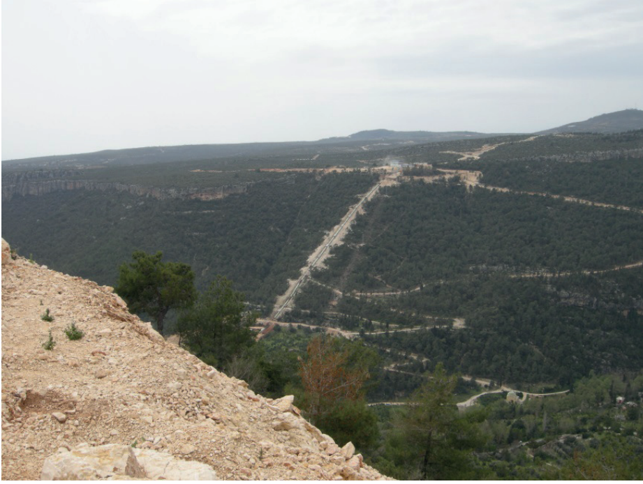
Şekil 10. Akarsuların tüneller ve kanallarla çevrilmesi ile yapılan bir HES (Birkapılı HES, MUT).
