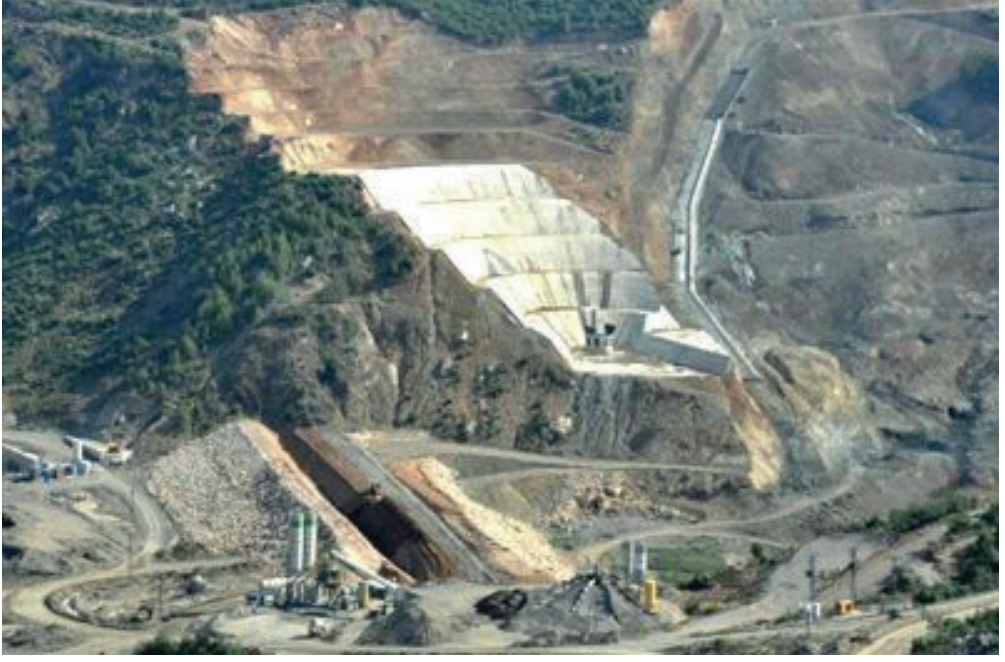
Şekil 11. Pamukluk Barajı inşaat evresi (Mersin).
