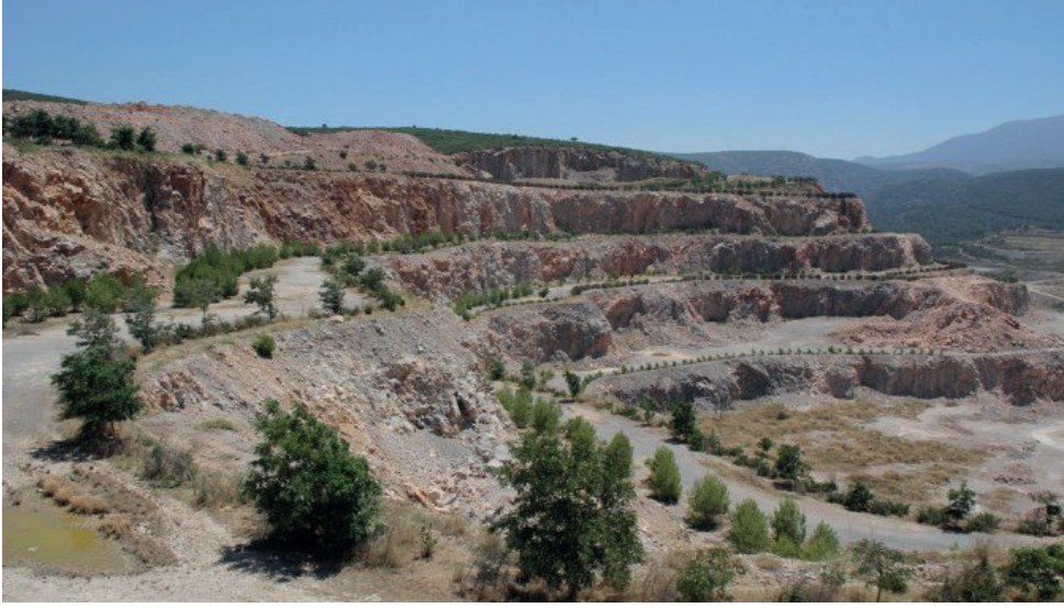
Şekil 12. İzmir Dikili' de 600 dekarlık açık işletmeye ait maden sahası iyileştirme çalışmaları
