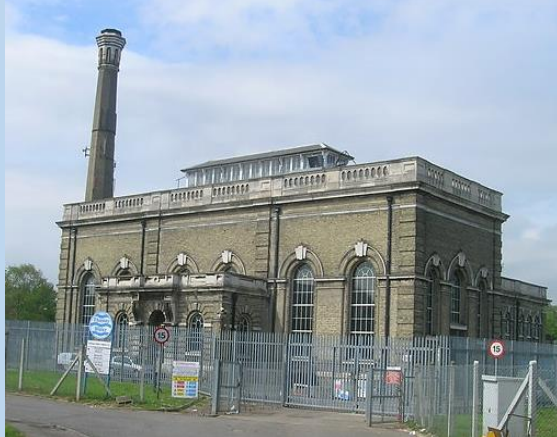
Bir zamanlar devasa bir buhar pompalama motoru içeren Viktorya dönemi pompa istasyonu, Londra, İngiltere,
