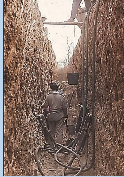
Ana kayaya hendek kazmak (modern sağlık ve güvenlik düzenlemelerinden önce)
