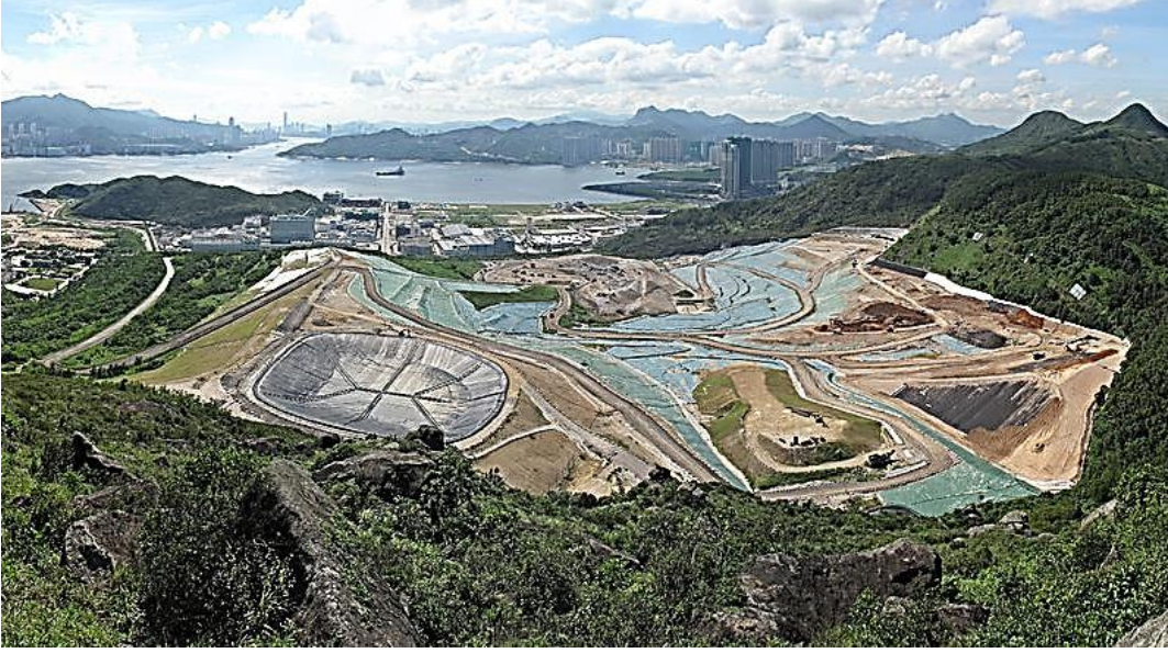
Şekil 6.10. Güney Doğu Yeni Bölgeleri Jeotekstil membran ile kaplı depolama sahası, Hong Kong
