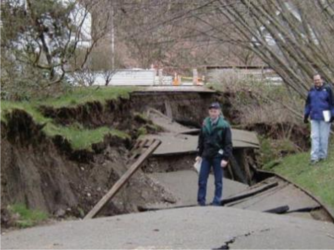
Şekil 25. Yanal yayılma sonucu meydana gelen yapısal hasarlar. Fotoğraf, 2001 Nisqually depremi sonrasında Puget Sound (Washington) bölgesinde çekilmiştir (Seattle Times'in izniyle)
