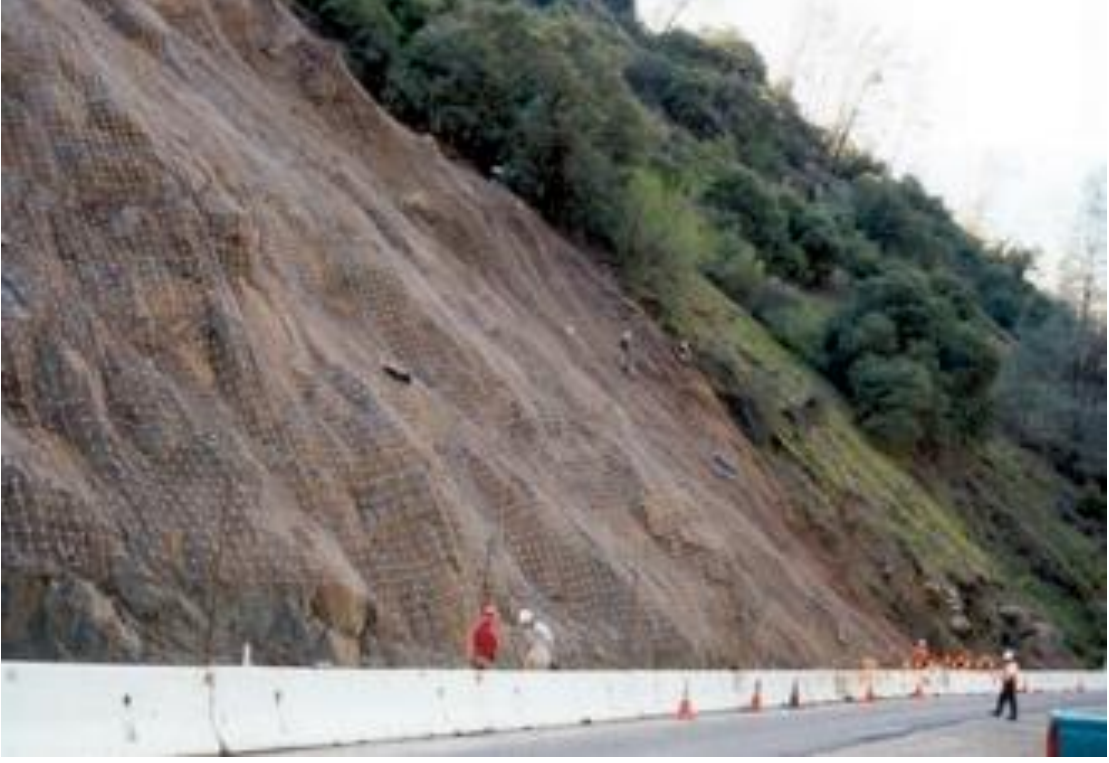
Şekil C 21. Düşen kayaları tutması için bir kaya şevine uygulanmış tel örgü kaplama örneği.
