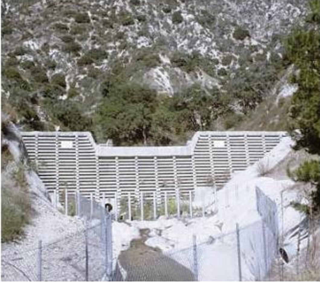
Şekil C 8. Betonarme kontrol barajının (Güney Kaliforniya, ABD) akış yukarisından görünümü (Fotoğraf: Los Angeles County Flood Control District).
