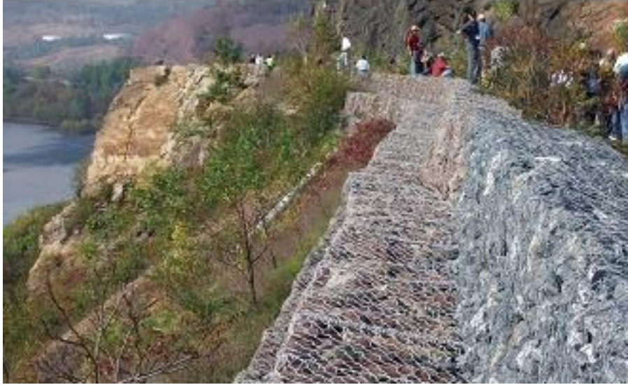
Şekil C 16. Gabyon duvarın şematik ve araziden görünümü (Şekil Kaynak 11'den) (Fotoğraf: Pocono Dağları, Pensilvanya, ABD, Lynn Highland (USGS)).
