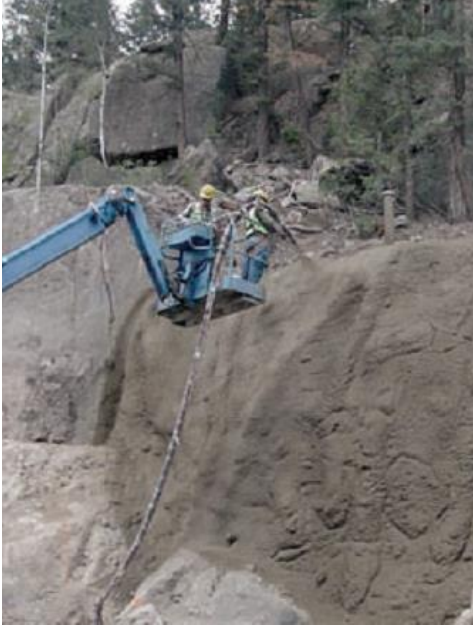
Şekil C 31. Wolf Creek geçidi (Rocky dağları, Colorado, ABD), kaya düşmelerine karşı püskürtme betonu uygulaması (Fotoğraf: Colorado Department of Transportation).
