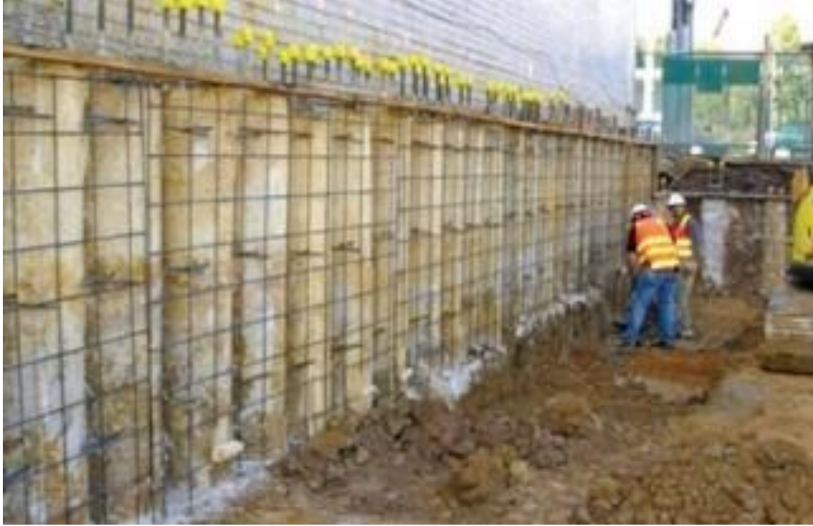
Şekil C 17. Beton fore kazık duvar (Brighton, Melbourne, Avustralya). Kazıkların önündeki demir hasır, püskürtme betonu uygulaması için yapılmıştır. (Fotoğraf: Basement Construction Services, Victoria, Avustralya, izniyle).
