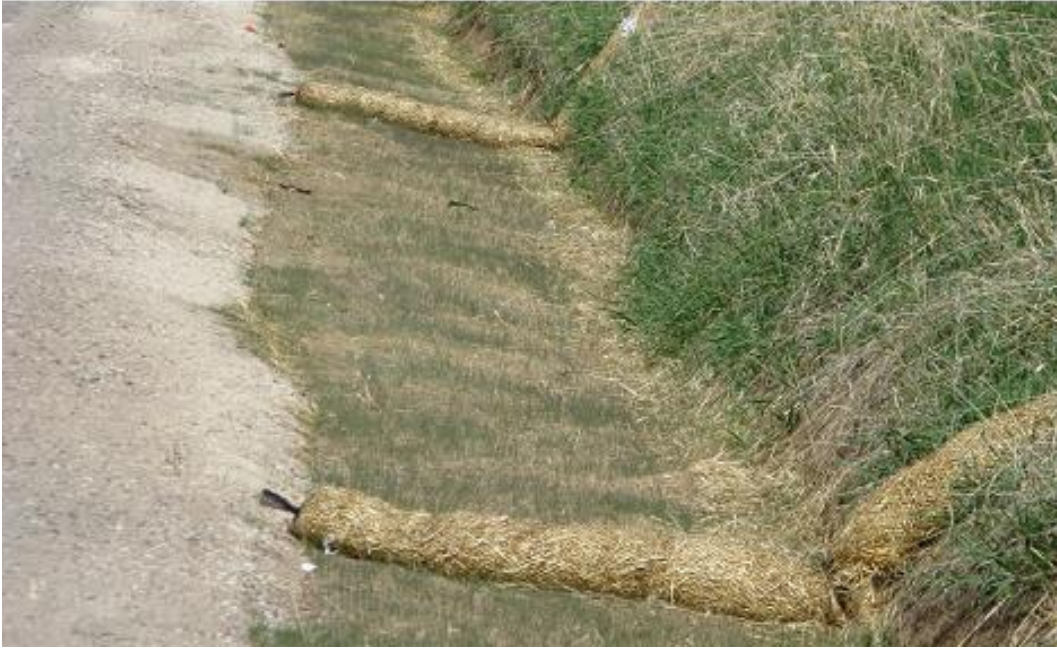
Şekil C 11. Yol kenarında kullanılan silindirik saman balyaları, sedimanların birikip, yerinde kalması ile tohumları yerinde tutarak ve çimlenmesini sağlayarak, yeni bitki örtüsü gelişim sürecine yardımcı olurlar (Fotoğraf: Lynn Highland, USGS).
