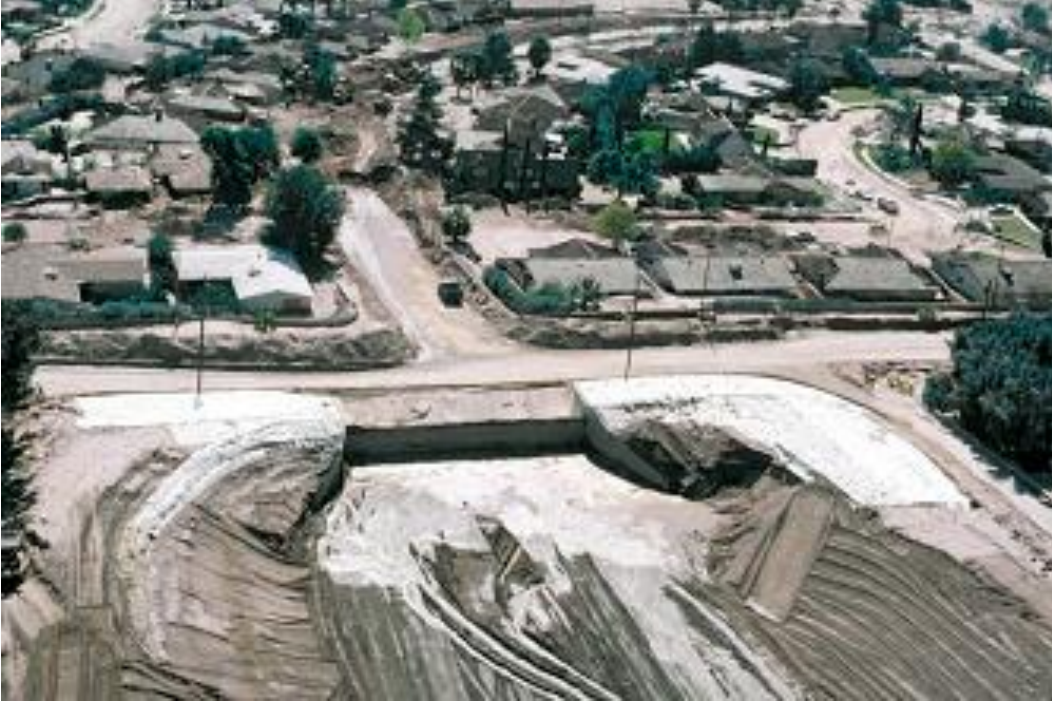
Şekil C 35. San Bernardino Kaliforniya, ABD) eteklerinde yapılan, moloz akması toplama havuzunun havadan görüntüsü (Fotoğraf: Doug Morton, USGS).
