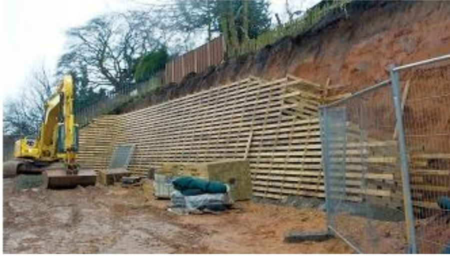
Şekil C 13. Keresteden yapılmış istinat duvarın şematik ve arazi görüntüsü (Şekil; Kaynak 11, Fotoğraf; PHI Grup, UK, izniyle).
