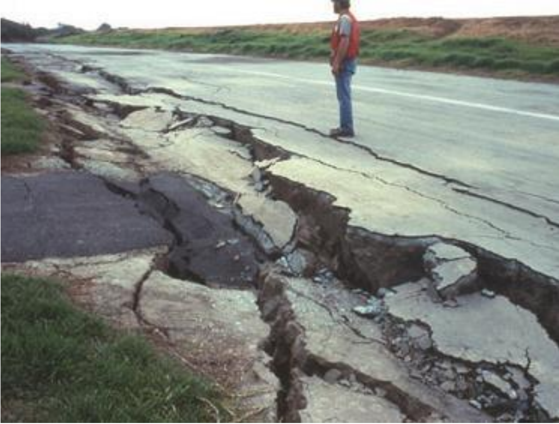
Şekil 12. 1989 Loma Prieta (Kaliforniya, ABD) depreminde meydana gelen yanıl yayılma sonucu yoldaki hasar (Fotoğraf: Steve Ellen, USGS).
