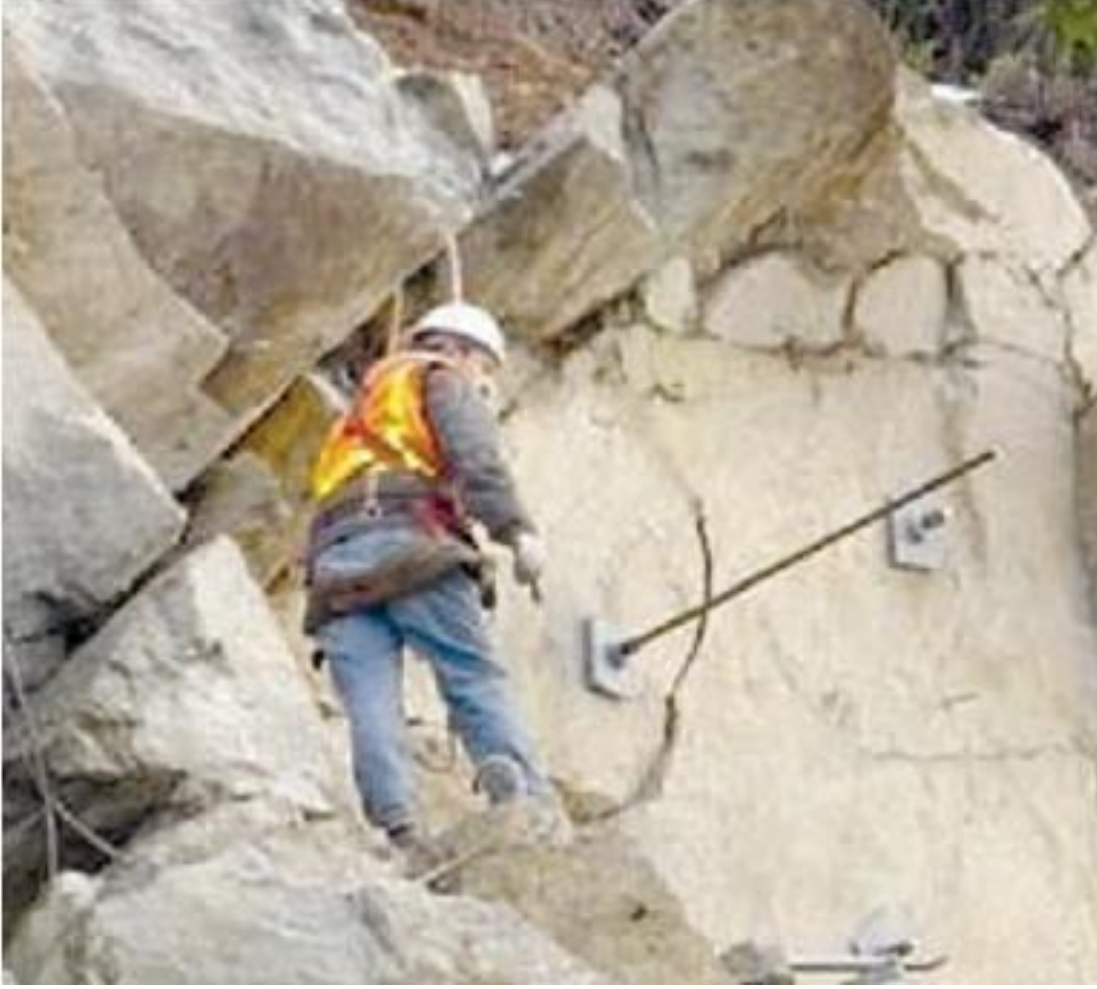
Şekil C 33. Doğal süreksizliklerin yapısı ve kaya saplaması uygulaması (Fotoğraf: Washington Department of Transportation, ABD).
