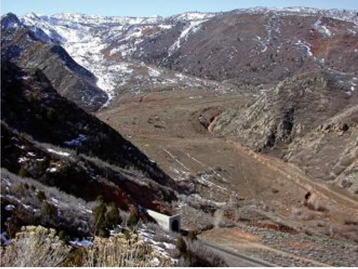
Şekil 42. Thistle heyelanı (Utah- ABD). 1983 tarihinde oluşan heyelan Spanish Folk nehrini bloke ederek arkasında oluşan set gölü nedeniyle Thistle yerleşimini sel basmıştır. Çoğu heyelan setleri burada gösterilenden çok daha küçüktür ve akış yukarıdan gelen sular üstten aşmış veya aşınmış olabilir. Bazıları ise daha büyük olup hasar gören karayolu ve demiryolu hatları heyelan kütesinin etrafından yönlendirilmelidir. Fotoğrafın alt bölümündeki beton tünel, demiryolu hattının Thistle heyelanının çevresindeki dağ içerisinden açılarak yeniden yönlendirildiğini göstermektedir.
