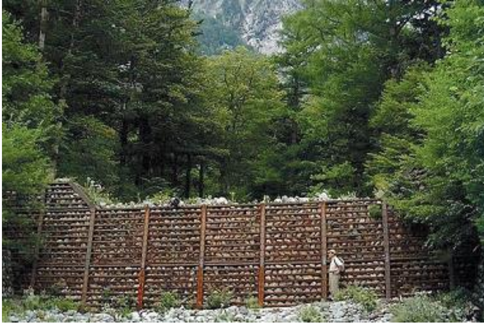
Şekil C 37. Kamikochi havzasında (Japonya) yamaç molozuna karşı yapılan bir istinat duvarı (Fotoğraf: Goncalo Vieira'nın izniyle).
