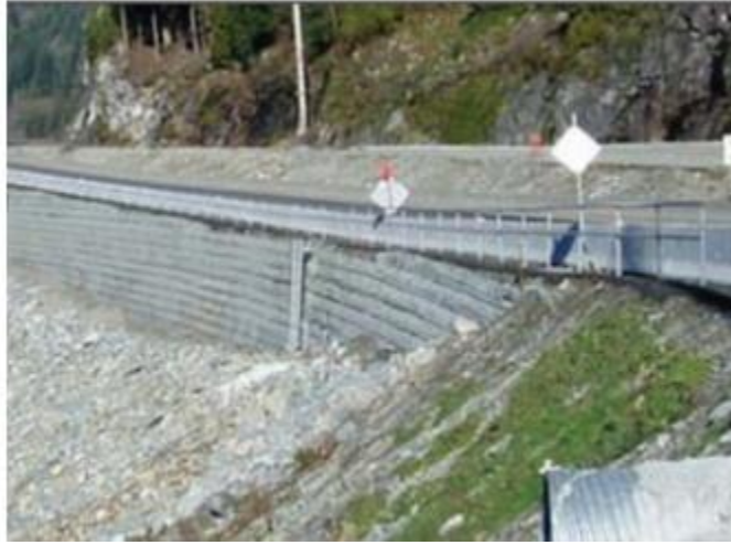
Őekil C 5. Kaya dolgu ile topuk desteđi uygulamasının Őematik ve arazi görünümü (Őekil kaynak 11'den alınmıřtır).
