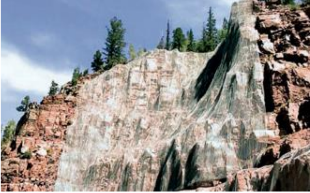
Şekil C 23. Kaya düşmesine karşı tel örgü kaya perdesi örneği (Foto, Doug Hansen, High Angle Technologies, Inc).
