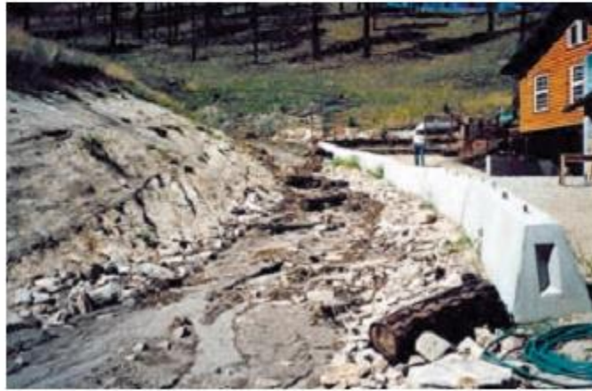
Şekil C 6. Kaya blokları kullanarak Dickson deresi (Montana, ABD) yatak kaplaması örneği (Fotoğraf ve şekil ABD Tarım Bakanlığı).
