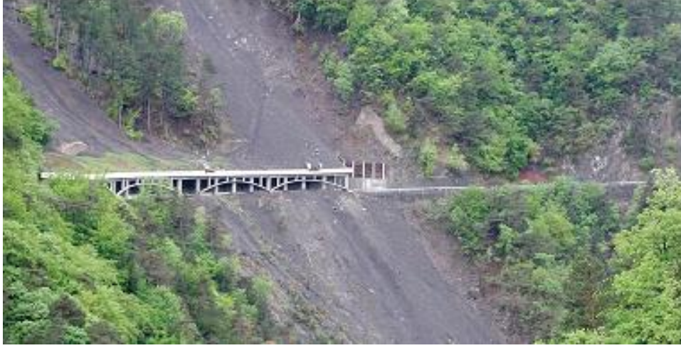
Şekil C 26. Montenyard (Fransa) bölgesinde yapılmış bir kaya çığı sundurma yapısı. Sundurmanın uzunluğu kısa olduğundan yapının sağ tarafında yol moloz akmalarından zarar görmüştür (Fotoğraf: Dave Giles, Jeoloji Danışmanlık Grubu, Portsmouth Üniversitesi, Birleşik Krallık).
