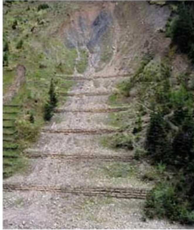
Şekil C 7. Bir beşik duvar kontrol barajının şematik gösterimi ve arazi uygulaması (Şekil kaynak 9; fotoğraf Trafoi'de (İtalya) çekilmiş olup, Santa Barbara, Kaliforniya ABD, "Erosion Control," Forester Communications).
