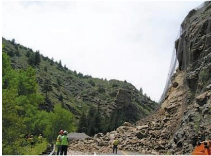
Şekil 4. Clear Creek Canyon (Kolorado, ABD) bölgesinde 2005 yılında meydana gelen bir kaya düşmesi/kayması. Heyelan nedeniyle yol birkaç hafta trafiğe kapanmıştır. Fotoğrafta ayrıca tehlikeli kaya yüzeylerine uygulanan bir kaplama türü olan kaya perdesi örneği de gösterilmektedir (Fotoğrafın sağında). (Fotoğraf: Kolorado, USGS).
