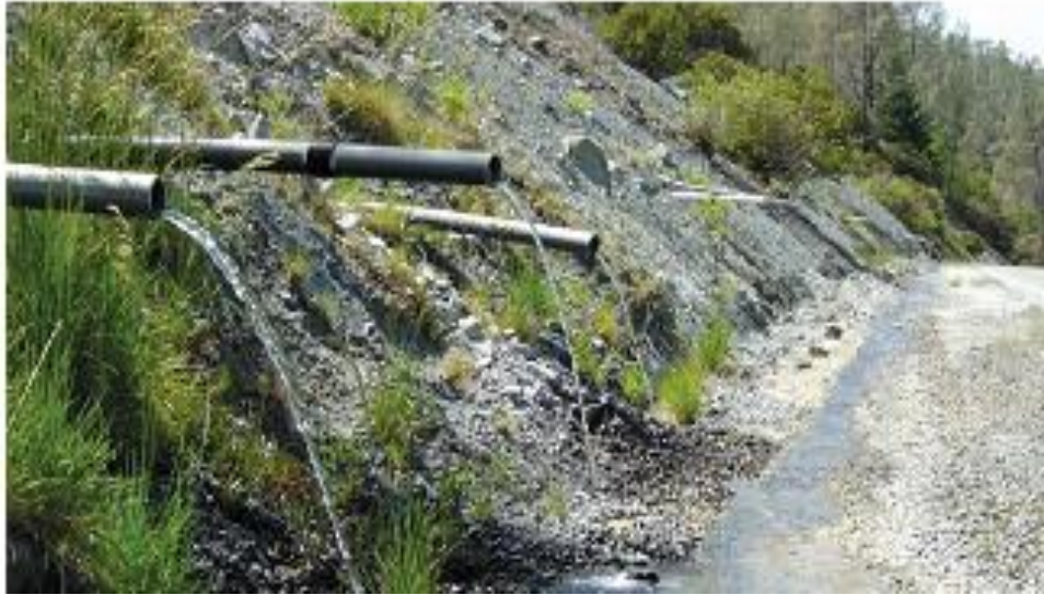
Şekil C 10. Drenaj borularının şematik (Kaynak 11) ve arazi görüntüsü (Fotoğraf: Andrew Alden).
