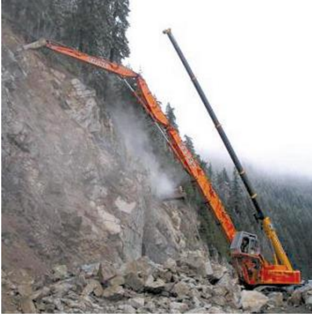
Şekil C 30. Patlatma tekniğine alternatif olarak, bir hidrolik kaya kırıcısı ile şev düzenlenmesi (Fotoğraf: Washington Department of Transportation, ABD).
