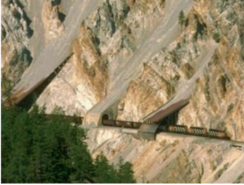
Şekil C 24. Pitquah kaya sundurmaları (rock sheds), Sundurmalar demiryolunun belirli bölümlerini çevreleyerek kaya düşmesi ve kaya çığlarından yapıyı korumaktadır (Foto: John Carter, www.trainet.org ).
