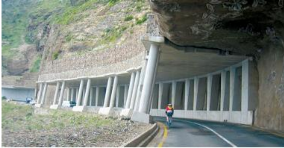
Şekil C 27Chapmans Peak Drive (Cape Town, Güney Afrika)'da güçlendirilmiş bir kaya çıkıntısı örneği (Fotoğraf: http://commons.wikimedia.org/wiki/Image:Chapmans_peak_dr.jpg .)
