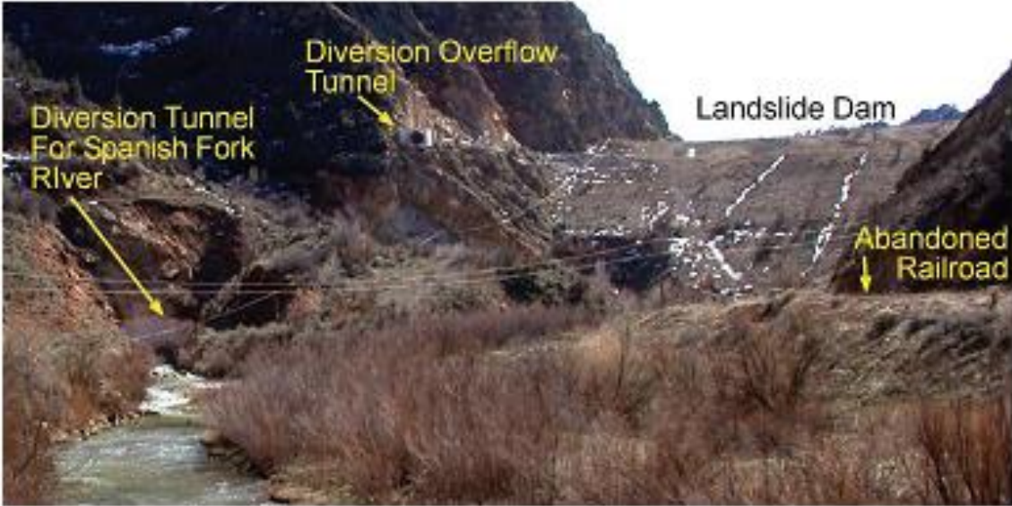
Şekil C 54. Thistle heyelan barajının etkisini azaltmak amacıyla yapılan alt ve üst derivasyon tünelleri (Fotoğraf: Utah, USGS).
