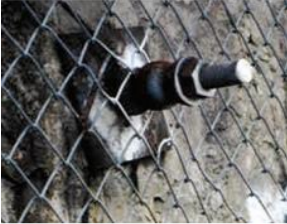
Şekil C 32. Kaya ankrajının (ankraj boyu 5m) yakından görünümü ve daha fazla koruma için kaya yüzeyine çelik hasır uygulaması.
